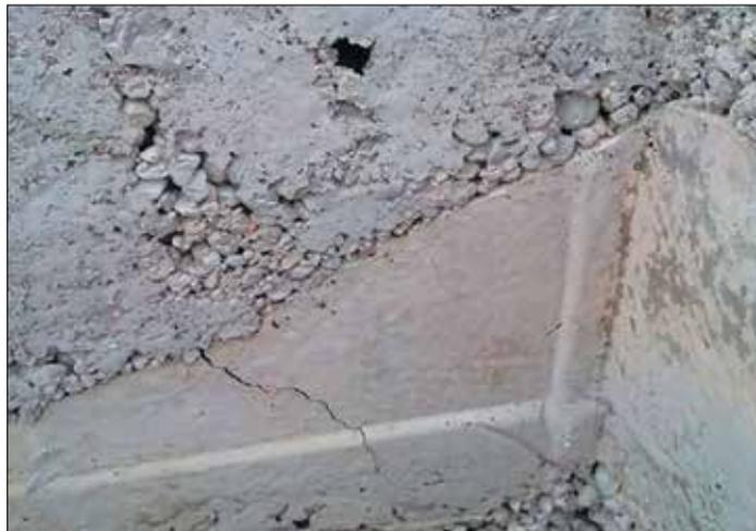
Рисунок 3 – Поверхностные дефекты бетона
