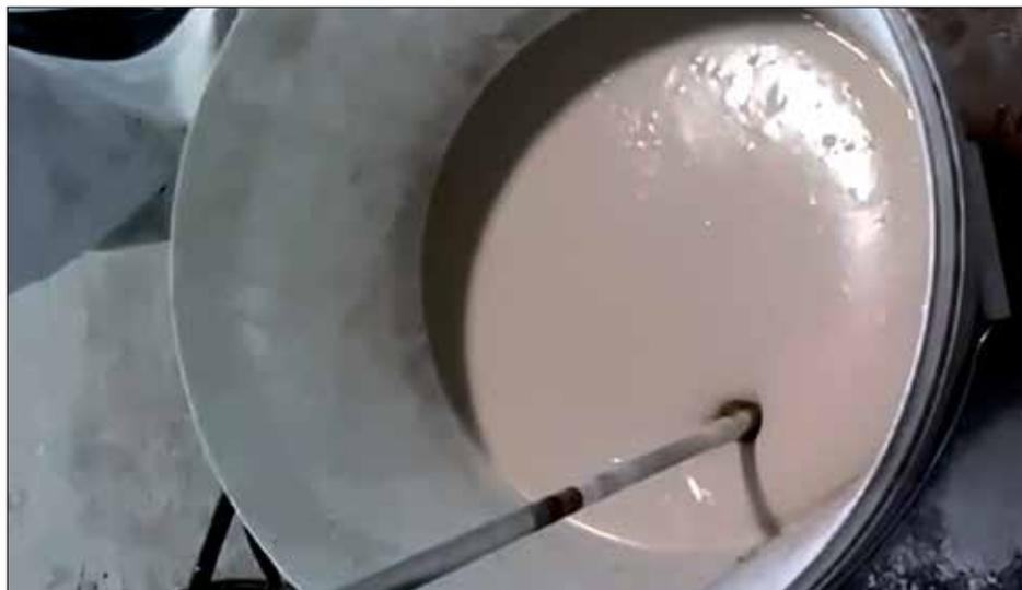
Рисунок В.5 - Приготовление растворной смеси «Скрепа 2К Эластичная»
