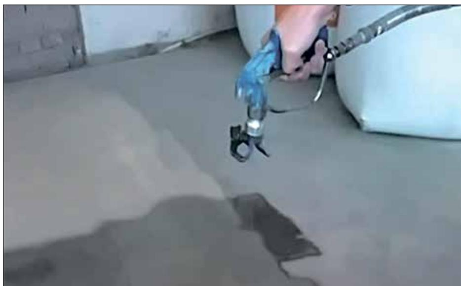
Рисунок В.6 - Нанесение растворной смеси «Скрепа 2К Эластичная» аппаратом безвоздушного нанесения
