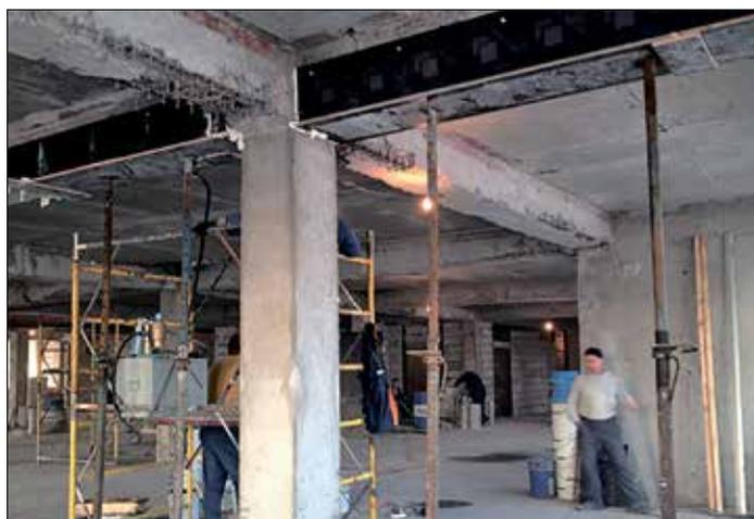
**Рисунок 11 – Установка опалубки**
